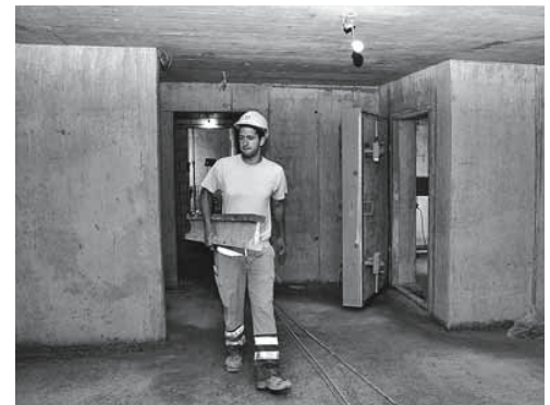
Bild 8: In Rohbauten muss eine Beleuchtung vorhanden sein.
