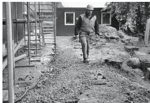
Bild 4: Dank des Magerbetons ist dieser temporäre Weg bei allen Wetterbedingungen sicher begehbar.
