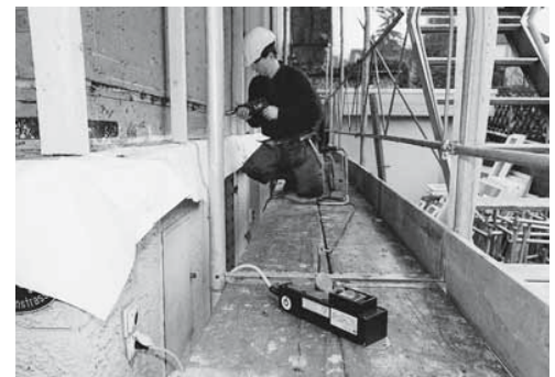
Bild 8: Wenn keine Baustromverteiler vorhanden sind: Mobile FI-Schalter anschließen.
